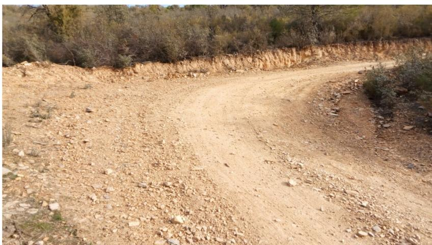
Imagen 8. Se observa la ampliación de uno de los senderos existente, ampliando notablemente su anchura en el ángulo de giro y desmontando en el lado de mayor cota para
